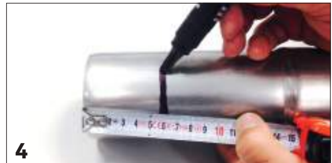
4 Marcatura quota d'innesto / Marking the insertion's depth
